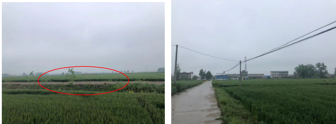
升压站及施工生产生活区现状
